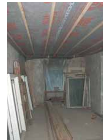
Um die Innenräume luftdicht zu machen, wurde beispielsweise unter den Decken eine diffusions-offene Dachunterspannbahn befestigt.
