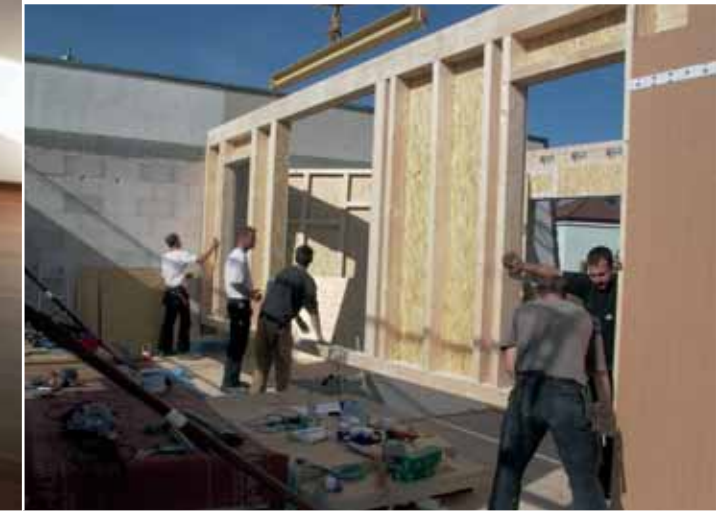
Aufstockung des dritten und vierten Obergeschosses mit Holzrahmen-Elementen: Zum Nachbargebäude hin musste aus Brandschutzgründen eine Mauer aus Porenbeton erstellt werden.
