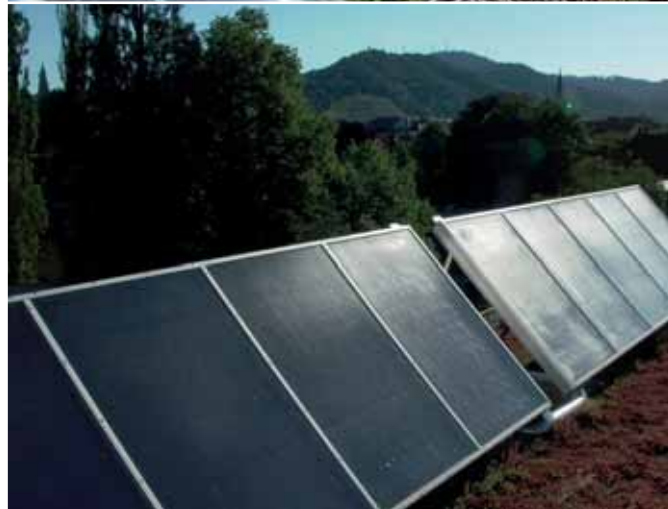
Aufgeständert auf dem Grühdach des Vorderhauses, unterstützen mehr als zwölf Quadratmeter Kollektorfläche Heizung und Warmwasser- bereitung.
