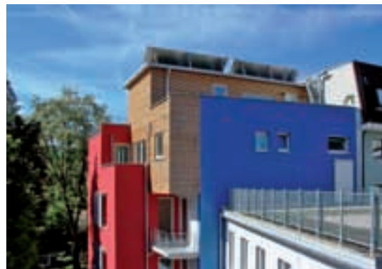
Blick auf die Nordseite des Gebäudes mit der Maisonnettewohnung in Holzrahmenbauweise
