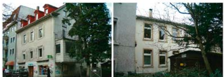
An dem rund hundert Jahre alten Wohnhaus waren im Lauf der Zeit viele Details verändert oder entfernt worden. Rechts das Rückgebäude.
