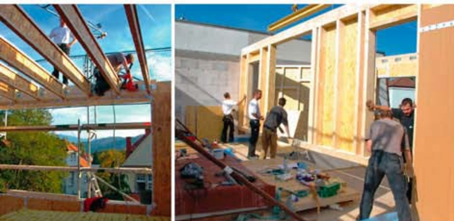
Der Aufbau des 3. Obergeschosses einschließlich der Maisonettewohnung war dank vorgefertigter Holzrahmenbauweise binnen zwei Tagen abgeschlossen.
